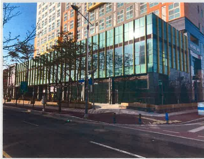
【본건 1층 전면 상가】
